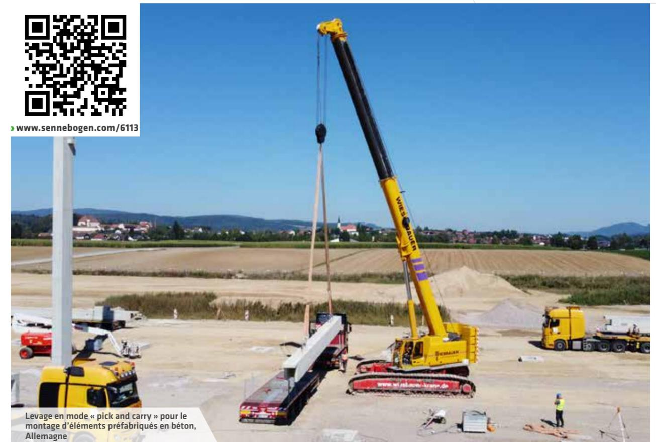
Levage en mode « pick and carry » pour le montage d'éléments préfabriqués en béton, Allemagne
